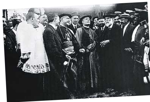
Gaudí presents the construction site of the Sagrada Família.
